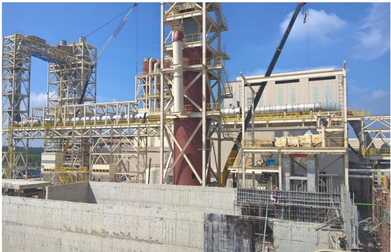
Công trình: Nhà máy Dongwpha Mdf Địa điểm KCN Minh Hưng 3, Tỉnh Bình Phước, Việt Nam. Quy mô: 1000 tấn thép
