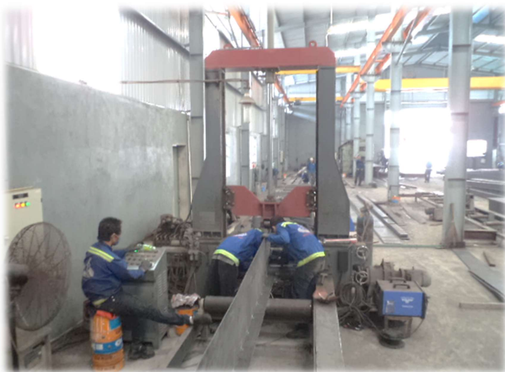
Công tác đính cấu kiện
