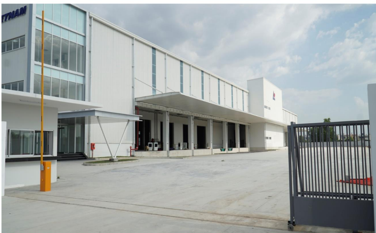
Công trình: Trung tâm kho vận Logitem Việt Nam Địa điểm: KCN Tân Đông Hiệp B, thị xã Dĩ An, Tỉnh Bình Dương Quy mô: 9000 m 2
