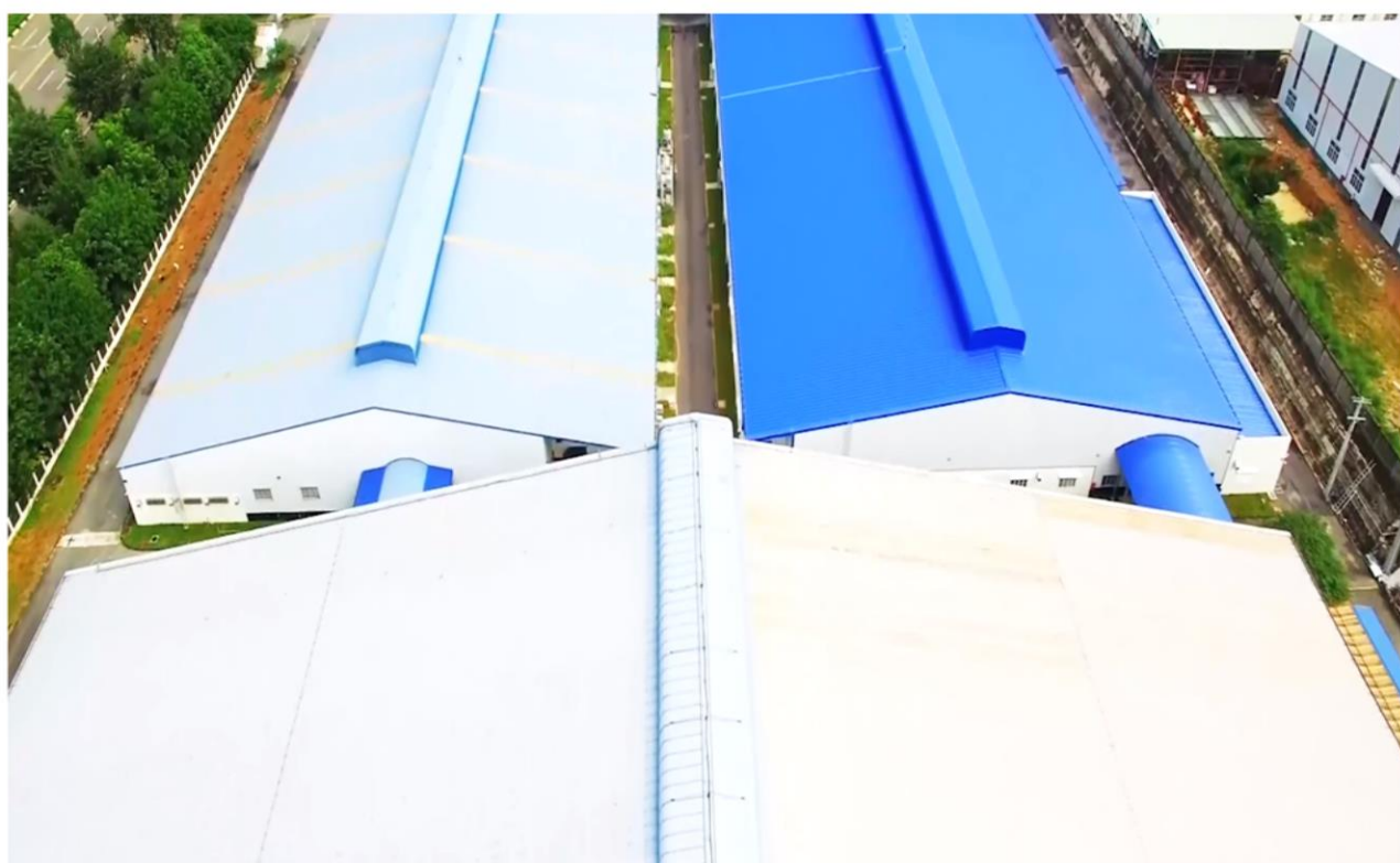
Công trình: Nhà máy KingJim giai đoạn 2 & 3 Địa điểm: KCN Mỹ Phước 3, Tỉnh Bình Dương Quy mô: 36000 m 2
