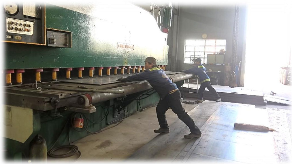
Công tác cắt thép
