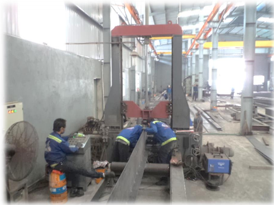
Công tác đính cấu kiện
